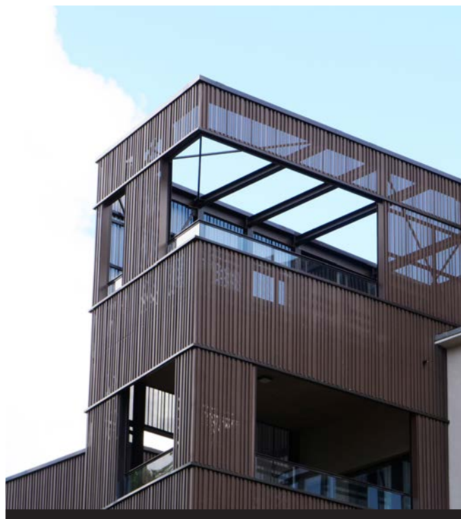
Les Brasseries de Neudorf, Neudorf (Luxembourg) - Architecte : STEINMETZDEMEYER - Aspect : PIGMENTO brun écorce
